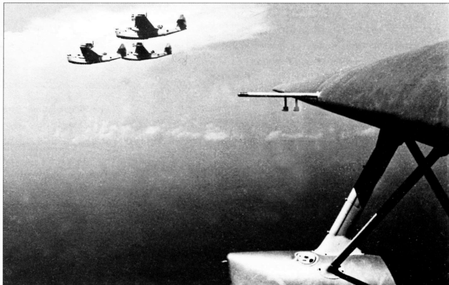
В воздухе звено МБР-2-М-34. На законцовке крыла хорошо видны держатели для т.н. «факелов Хольта» There is MBR-2-M-34 flight in the air. The holders for so called «Holt torches» are vividly seen on the wing tip
